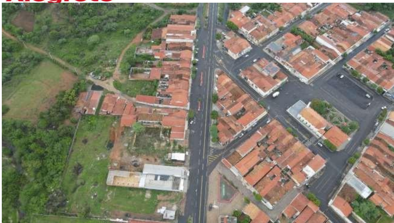
Entrada principal para o centro da cidade
